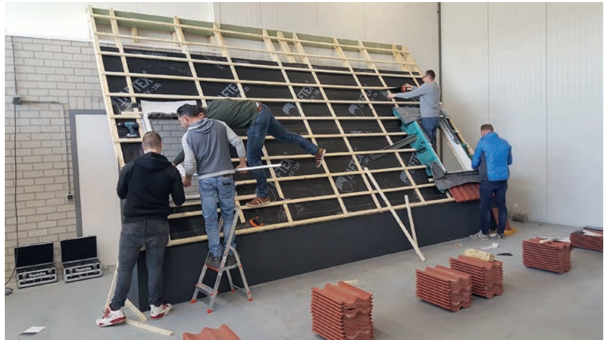
In de praktijkruimte staat een pannendak op ware grootte. De cursisten, verdeeld in twee groepen, moeten een dakraam monteren.
