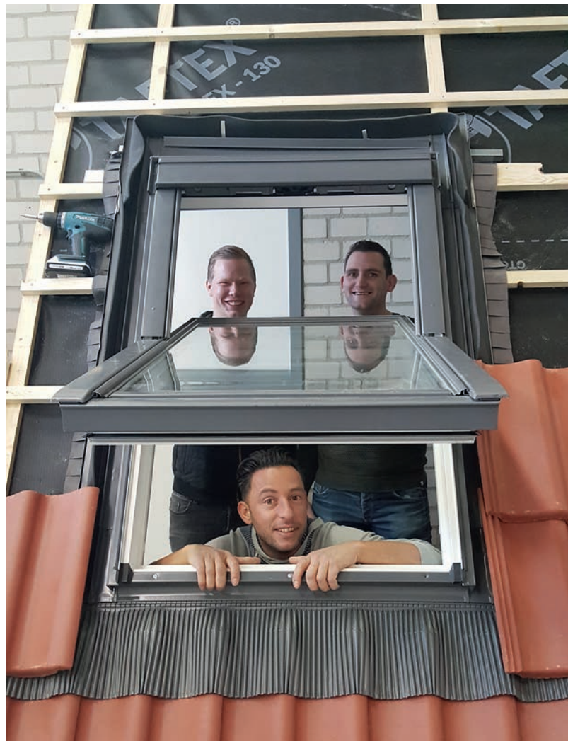
Cursisten Nikos Kounoupiotis (vooraan), Jan de Vos en Wesley van der Voort (linksachter) monteren in de praktijkruimte een Velux-raam.
