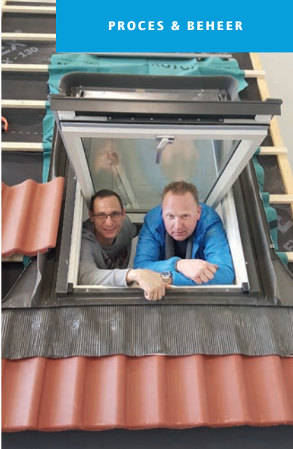
Rob Morsink en Danny van Duinen gaan aan de slag met een dakraam van Fakro.
